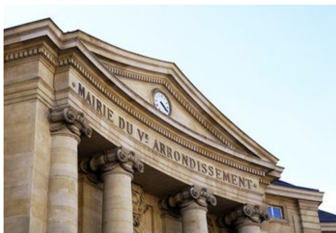
Halte de nuit située dans les locaux de la Mairie du 5 e arrondissement (Foyer Geneviève de Gaulle-Anthonioz)
