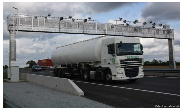
Un portique de contrôle de la taxe
