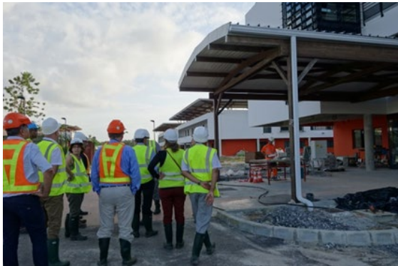
Le chantier du nouvel hôpital de l'ouest guyanais (Saint-Laurent-du-Maroni)
