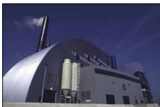
Unité d'incinération d'ordures ménagères
