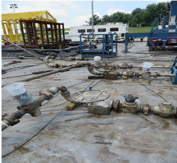
Un séparateur (liner) étanche est disposé sur la surface des quelques hectares du site de forage. La cage jaune protège une tête de puits de gaz déjà forée attendant la mise en production d'un autre puits en cours de forage à quelques mètres.
