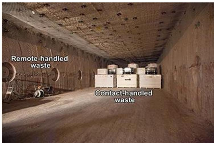
Vue d'un alvéole avec deux types de déchets radioactifs (*source* : DOE).
