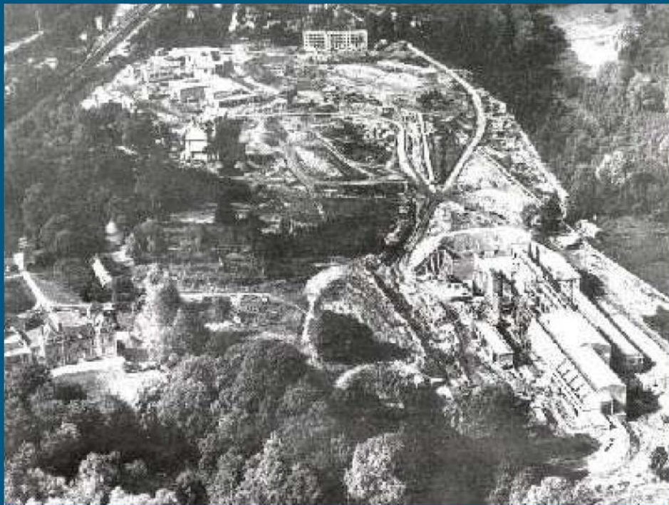
Chantier du LAL en octobre 1957.
