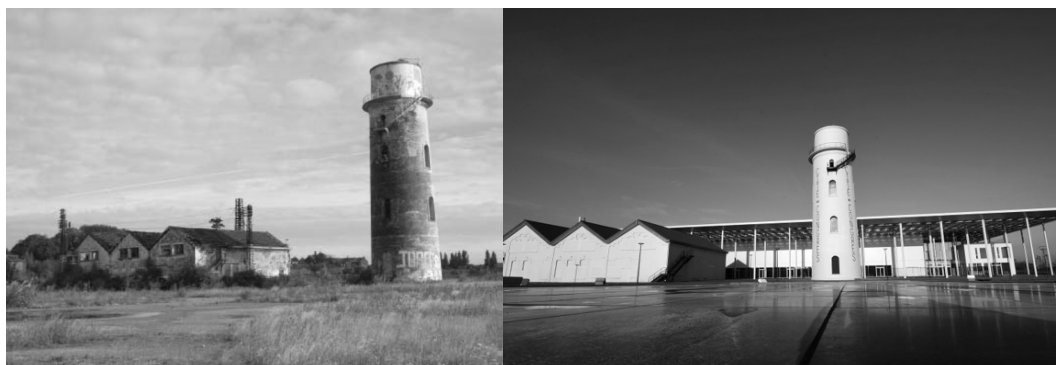
La friche des Rives de l'Escaut (Anzin), avant et après dépollution et aménagement
