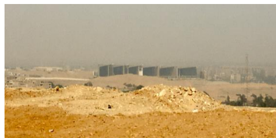
Chantier du Grand Musée égyptien (GEM) à Gizeh
