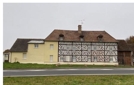
Maison divisée en deux logements dont l'une des parties a été isolée par l'extérieur
