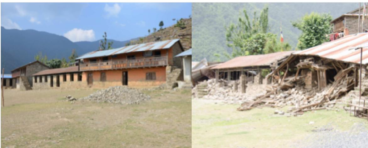
Fig. 9. L'école principale de Salmé en 2014 (© B. Ripert) et après le séisme (© D. Blamont)
