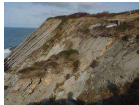
Les glissements bancs sur bancs - Corniche Basque (13000 m 3 )
