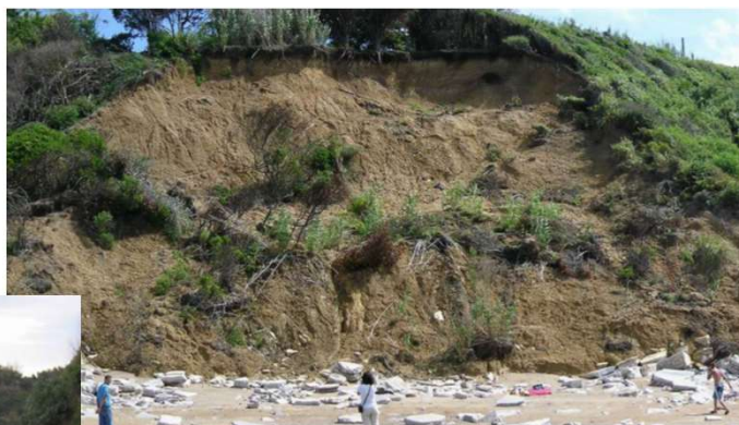
Les glissements de terrain circulaires - Guéthary (7500 m 3 )
