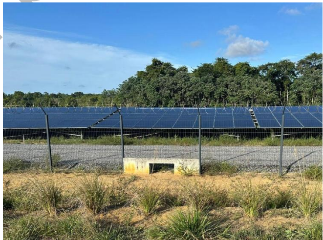
Ouverture aménagée dans une clôture protégeant des installations photovoltaïques destinée à faciliter le passage de tortues
