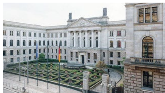
Le bâtiment du Bundesrat, construit en 1904 pour la Chambre haute du Parlement prussien.
