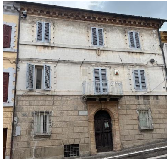
Façade de la chapellenie de Lorette vue de la rue
