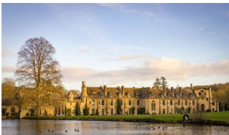
L'abbaye des Vaux-de-Cernay a été transformée en établissement hôtelier.
