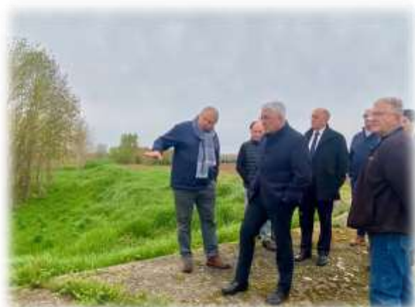
Visite des rapporteurs dans le Lot-et-Garonne : présentation d'une digue de protection contre les crues sur le territoire de Val de Garonne Agglomération
