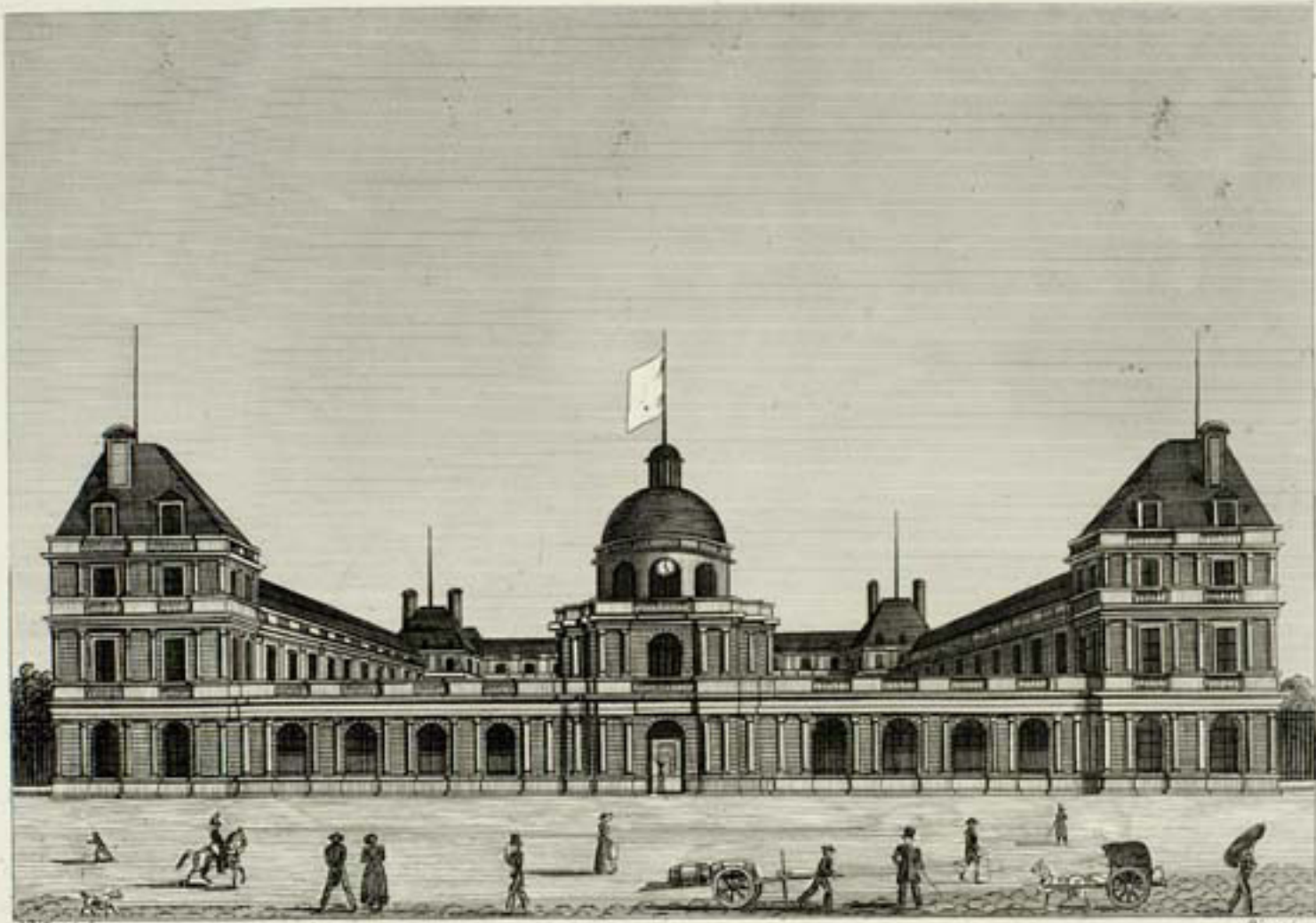
VUE DE LA FACADE DU PALAIS DE LA CHAMBRE DES PAIRS
