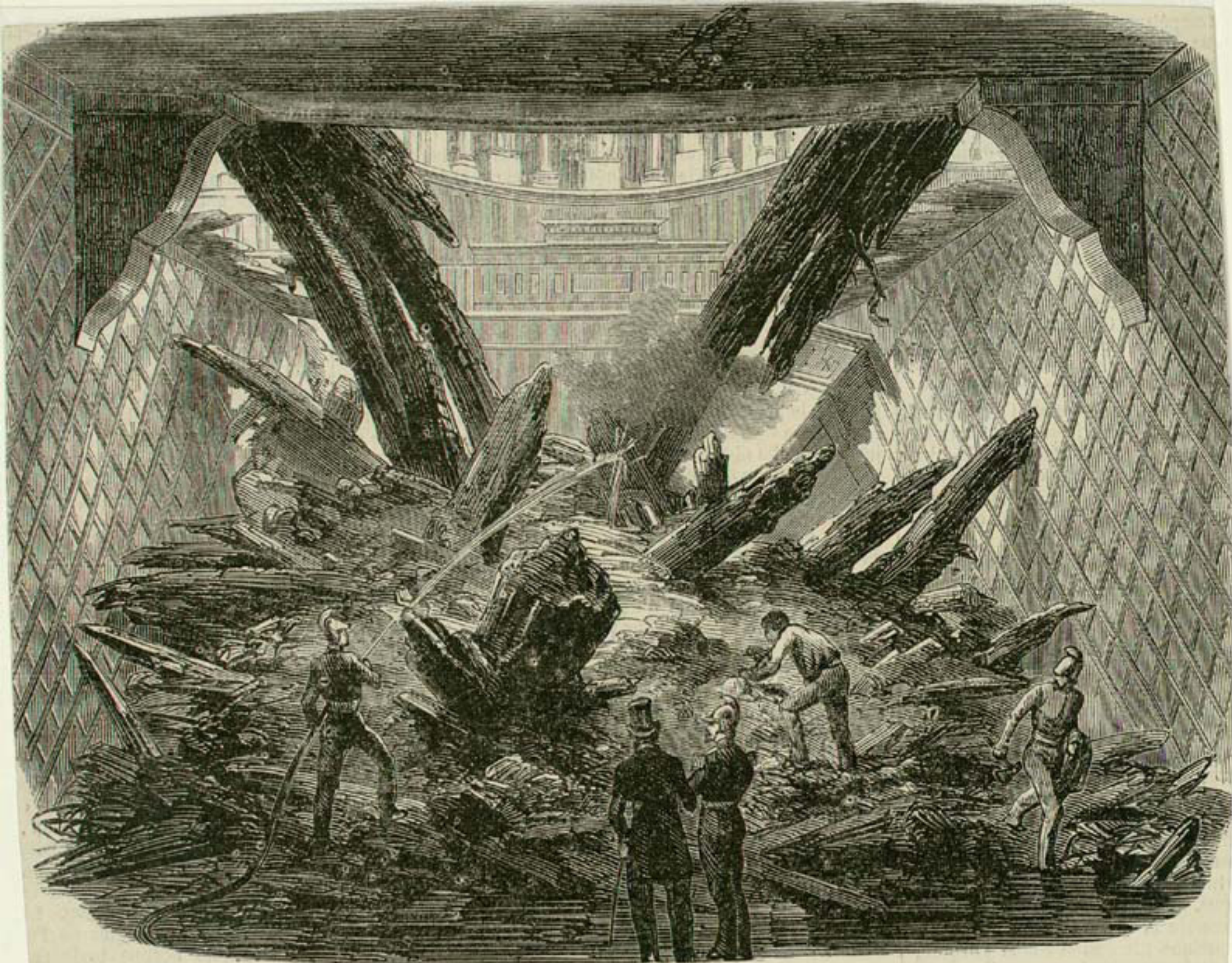
LES DÉBRIS DE LA COUPOLE APRÈS SA CHUTE A TRAVERS LE PLANCHER DE LA SALLE DES SÉANCES.
