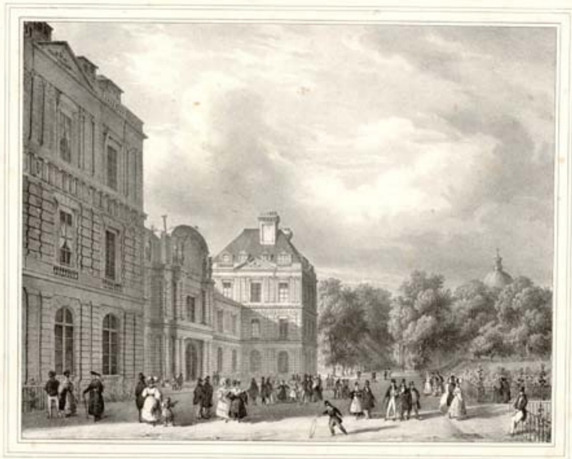
FAÇADE PRINCIPALE DU CÔTÉ DU JARDIN,
