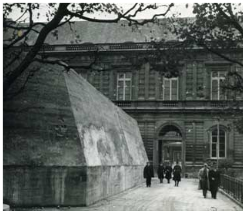
Blockhaus surmontant l'abri souterrain contigu à la façade est du Palais
