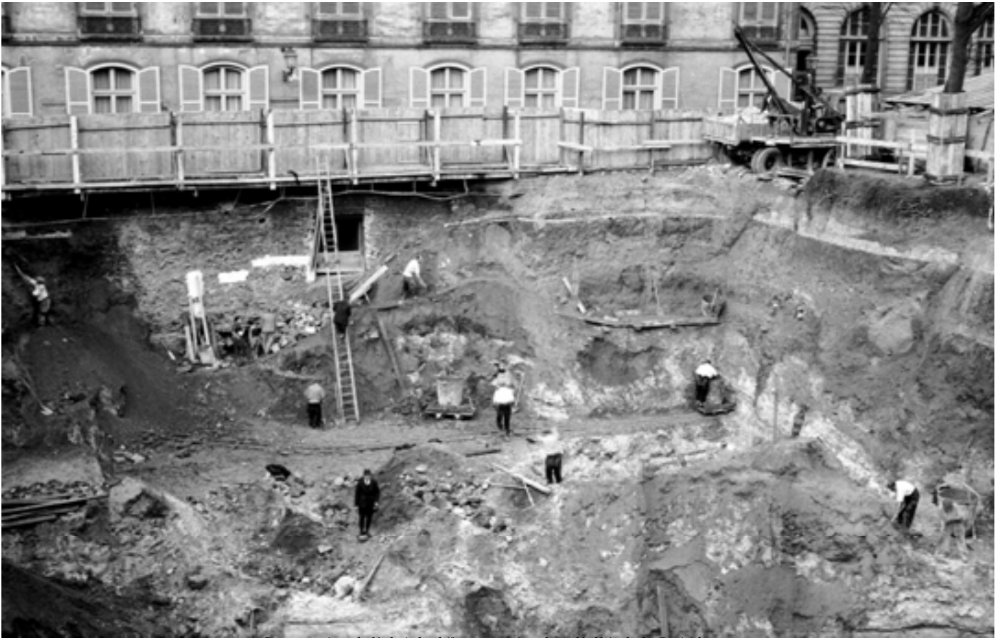
Construction de l'abri de défense passive dans l'allée de la Présidence
