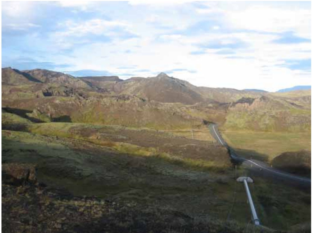
Les conduites d'eau chaude qui alimentent l'Islande ponctuent ses paysages.
