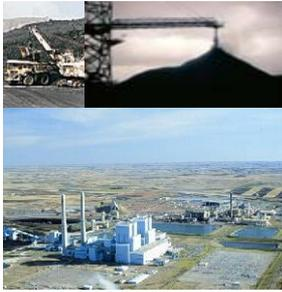
Le remplacement d'une centrale thermique d'un rendement inférieur à 30% par une centrale de nouvelle génération d'un rendement supérieur à 40% permet de réduire de 25% les émissions de CO<sub>2</sub>, à production
