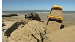
Rechargement en sable
