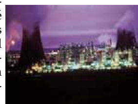
Usine Sasol -Afrique du Sud
