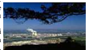
Centrale nucléaire de Tricastin - EDF
