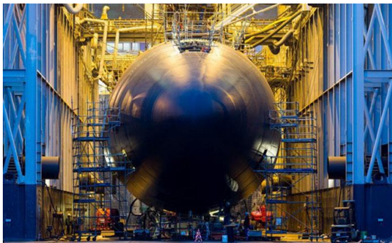
Chantier du SNLE Le Téméraire à Brest © Chantiers GUELTY
