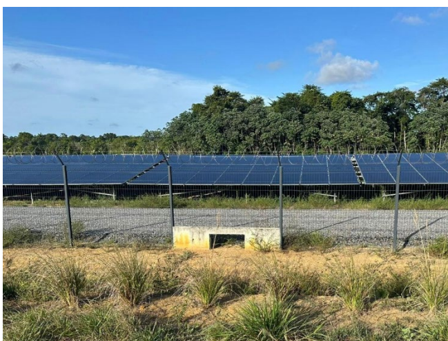
Ouverture aménagée dans une clôture protégeant des installations photovoltaïques destinée à faciliter le passage de tortues
