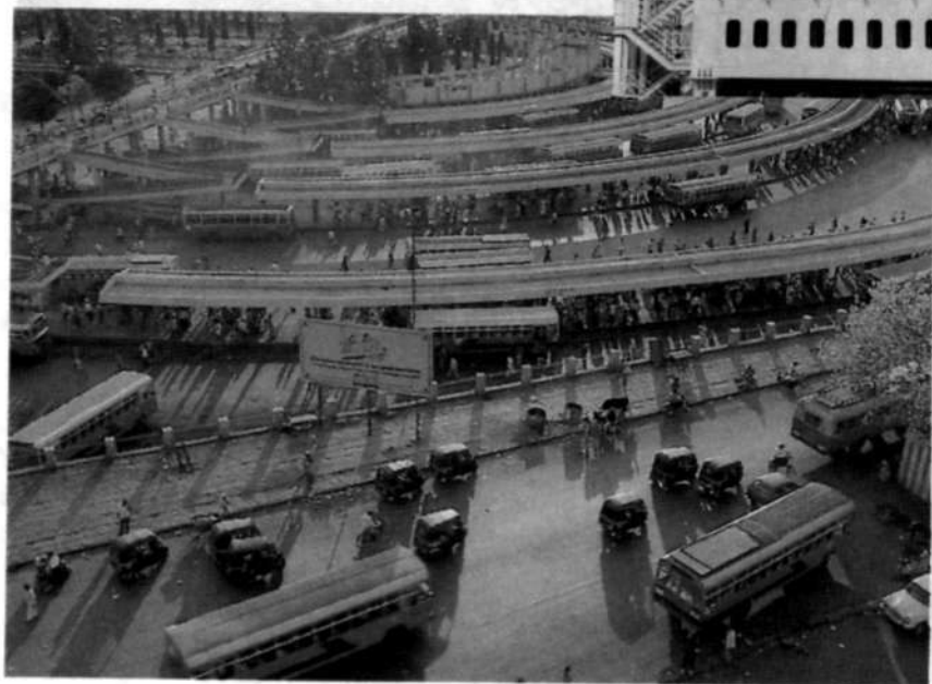
L'infrastructure du terminal de bus de Bangalore ↴
